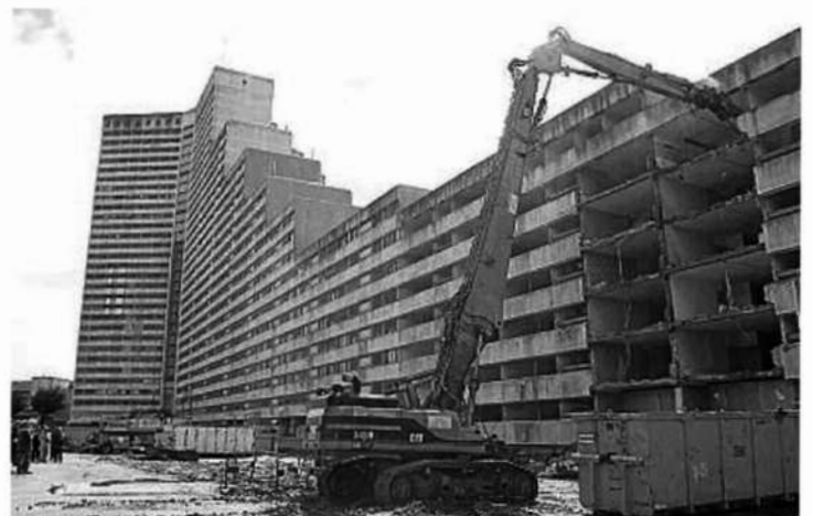
La brèche est taillée entre le 17 et le 23, avenue de l'Angevinière. Elle va libérer un grand passage ouvert sur le parc situé en arrière du bâtiment.
