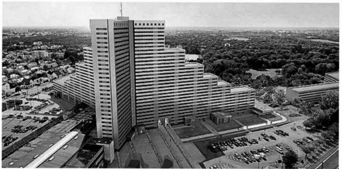
L'immeuble, habillé d'aluminium, aura totalement changé de physionomie en 2014.
