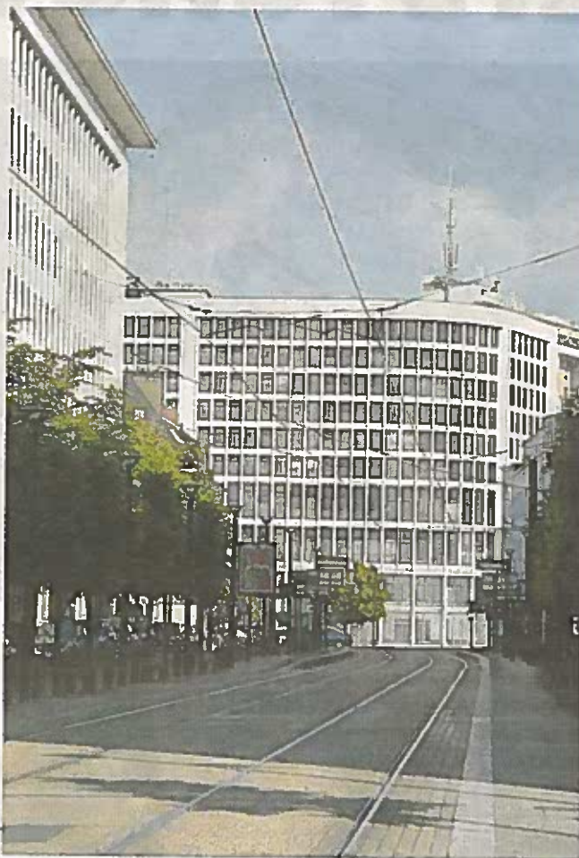
L'esprit d'origine du bâtiment qui s'inscrit dans la perspective de la Poste et de la Caf est mis en valeur. Image Cabinet Barré-Lambot
