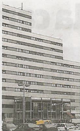
Les travaux de l'immeuble du Sillon-de-Bretagne avancent.
