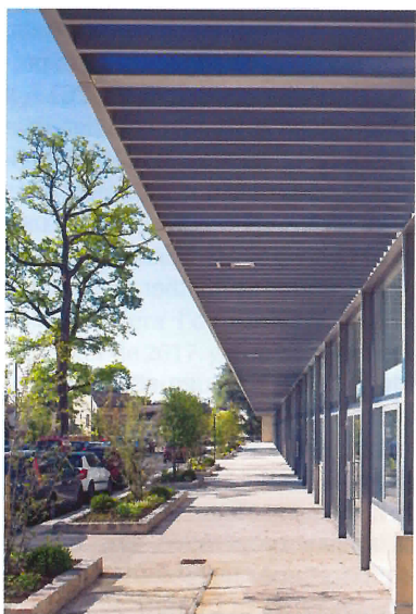
Les espaces sous pilotis, qui servaient de parking en rez-de-chaussée de deux des immeubles, ont été utilisés pour créer quelque 1 700 m 2 de commerces. © S. Grazia
