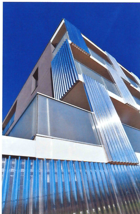
Bardage couleur aluminium en façade pour Les Roselières. Maîtrise d'œuvre : LTA Architectes/TPFI/Paysage de l'Ouest. © V. Jacques
