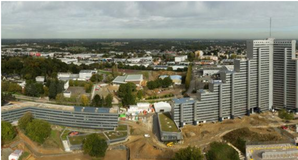
Le Sillon de Bretagne, en 2013, durant les travaux de réhabilitation (DR).
