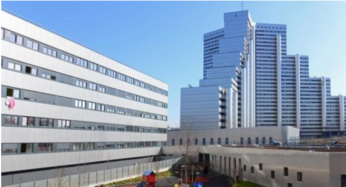
Le Sillon de Bretagne, situé à Saint-Herblain, après sa réhabilitation par Harmonie habitat (©Vincent Jacques).
